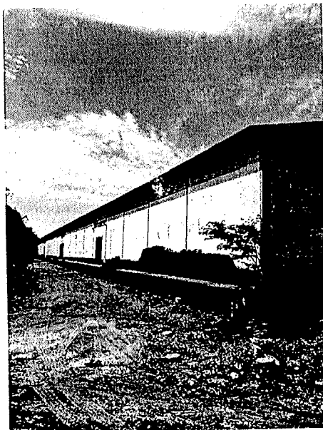
Figura 8: A estrutura externa da edificação é composta por paredes de vedação em alvenaria, que recebem acabamento em reboco e pintura. A alvenaria é reforçada por pilares e colunas estruturais de concreto armado. A edificação se eleva sobre uma plataforma de concreto que funciona como base. A cobertura é composta por telhas metálicas (tipo zinco).
