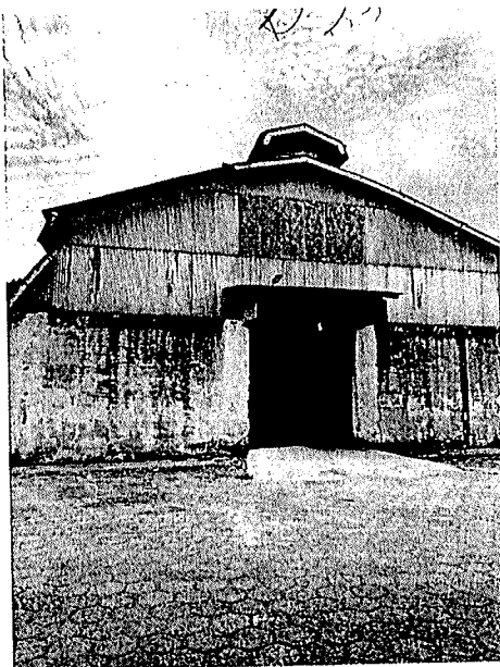
Figura 14: O fechamento da empena frontal é realizado em sistema misto. A porção inferior da parede é construída em alvenaria de vedação, que recebeu revestimento de argamassa e pintura. A porção superior da empena utiliza chapa metálica corrugada (telhas de zinco) como material de vedação. A cobertura da empena possui um respirador no topo. O acesso principal é caracterizado por um vão amplo e central, típico de entrada de veículos industriais.
