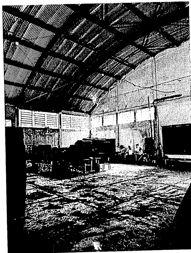
Figura 17: O interior do galpão é definido por um sistema estrutural de cobertura metálica de formato tradicional (duas águas), composta por tesouras (treliças) e terças em perfis metálicos. A sustentação vertical é realizada pelas paredes de alvenaria, que servem de apoio e contêm pilares embutido. A cobertura é realizada com telhas metálicas corrugadas (tipo zinco). O piso é de cimento polido. O ambiente conta com janelas elevadas que utilizam um sistema de venezianas horizontais.
