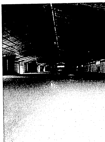
Figura 10: O interior é caracterizado por um vão livre. O piso é de cimento polido. O sistema de cobertura é suportado por uma estrutura metálica robusta, composta por tesouras (treliças), terças e contraventamentos em perfis metálicos. A cobertura é realizada com telhas metálicas corrugadas (tipo zinco). O fechamento lateral interno é realizado por paredes de alvenaria.
